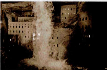
Zusammenbruch der Unterstadt
